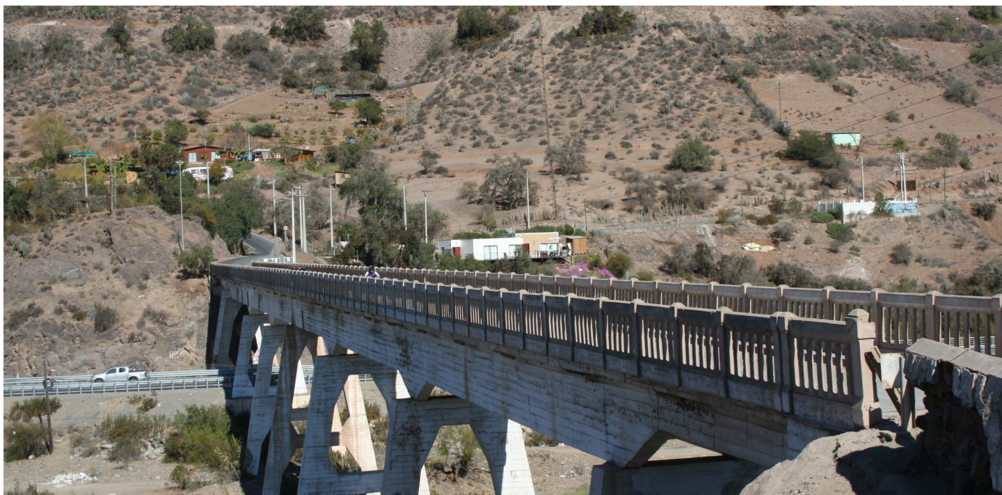
Puente fiscal que comunica a Ovalle con el sector de Santa Catalina.
